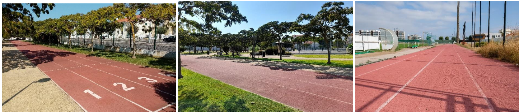
Figura 27. Instalações de atletismo (Esq. E centro - Parque Desportivo do Valbom; Dir. – Complexo Desportivo GDA)
